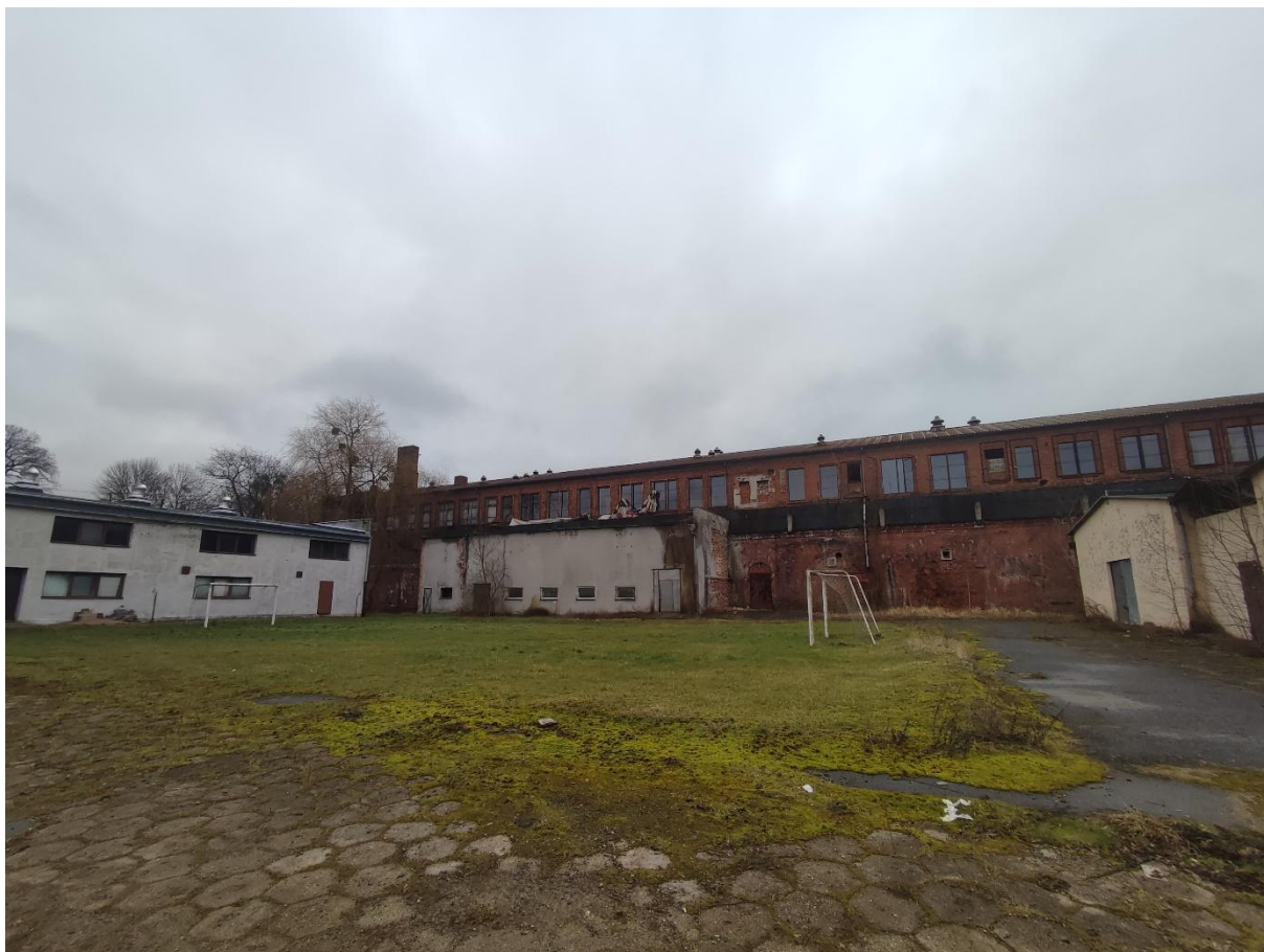
Fotografia 4. Widok na wnętrze obszaru północnego oraz nadbudowę schronu
