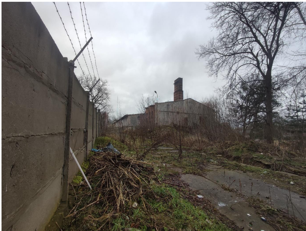
Fotografia 1. Widok na tereny w otoczeniu dawnego schronu tzw. Hangaru Zachodniego
